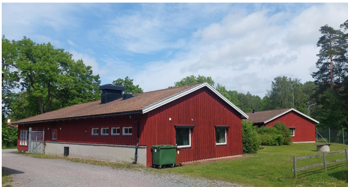
Figur 3b. Enplansbyggnaden som ligger närmast vägen är mer modern och förefaller inte lika lämplig som kolonilokal som ladan (bild 3a). Byggnaden har inte undersökts invändigt.
