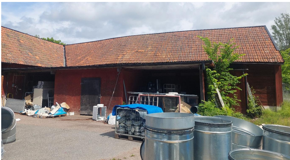
Figur 3a. Planområdet består till stor del av en grusplan. Två större byggnader ligger på tomten varav den ena är en äldre lada (denna bild) där loftet är oinrett.
