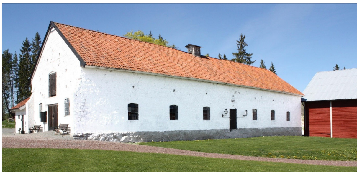
Fähuset från 1856. Väggarna är murade av gjuten slaggsten från masugnen.
