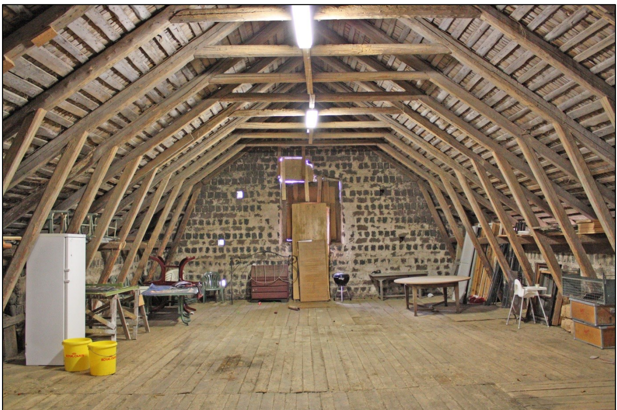
Höloftet med murade gavelrösten av slaggsten. De ursprungliga takstolarna och undertaket med stickspån är väl bibehållna.
