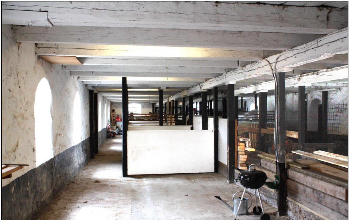
Fäbusets inredning är delvis ändrad då det använts som häststall under 1900-talet. Foderbordet finns kvar med utgödslingsrännorna har gjutits igen. Interiören har fina arkitektoniska kvaliteter genom bjälklagets stora spännvidd och de välvda fönsternischerna.
