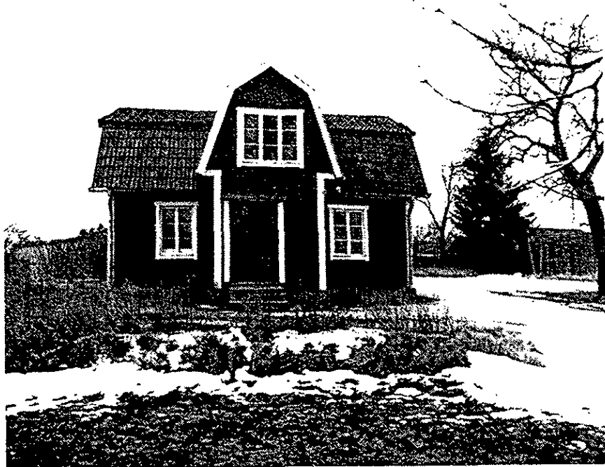
Granbolundstorpet sett från öster (Sätunavägen).
