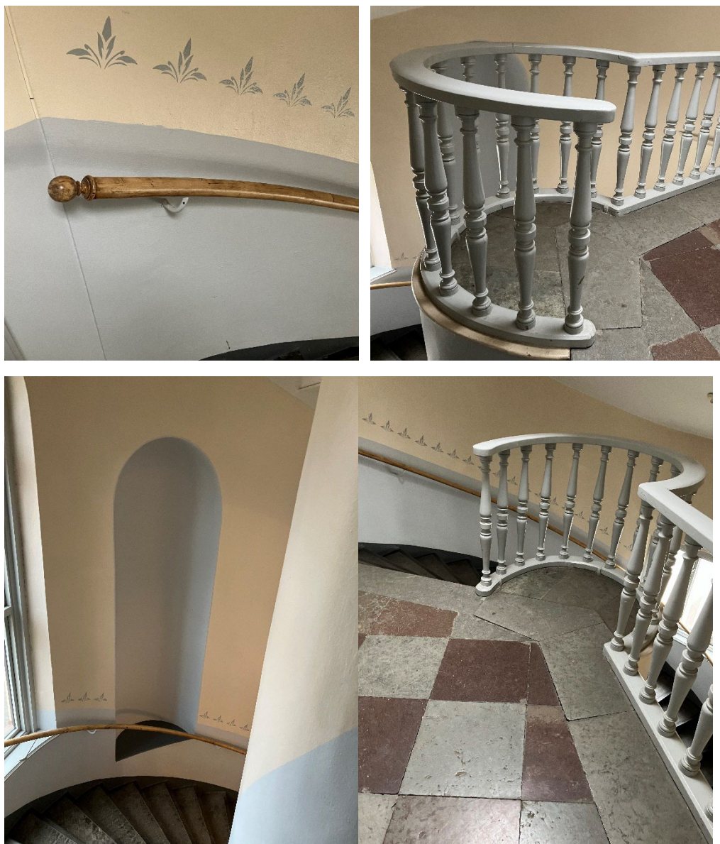
Figur 22 Trappans detaljer: räcke och nisch.
