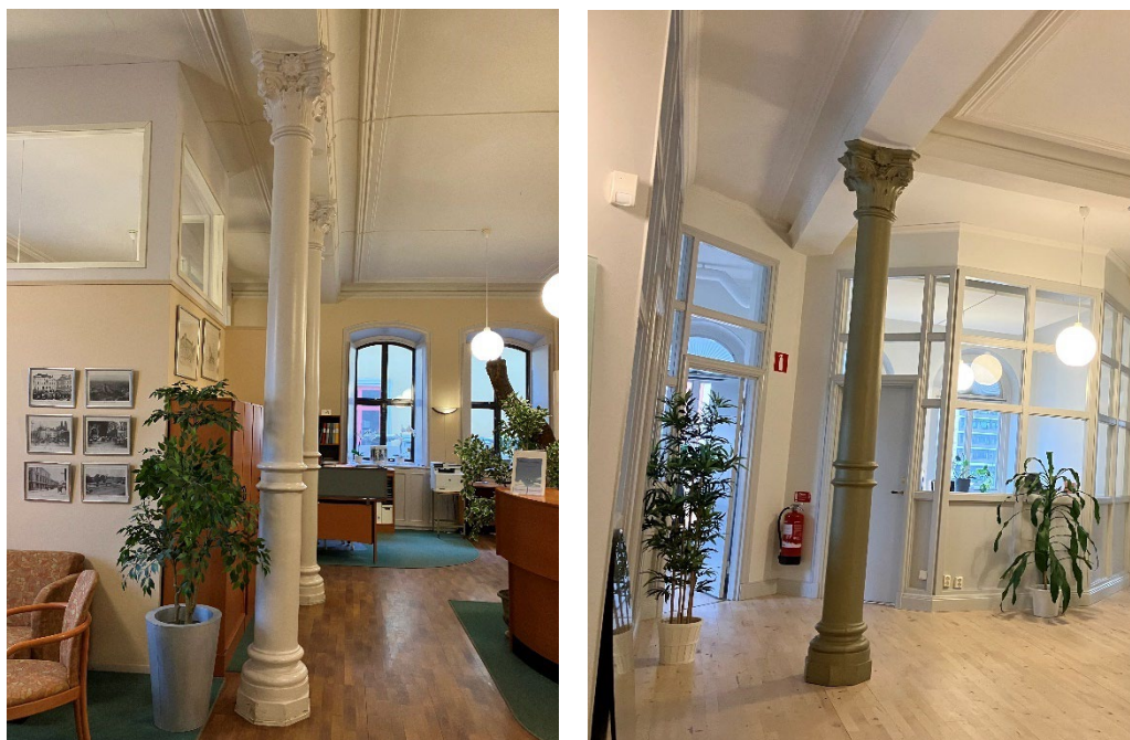
Figur 19 Ursprungliga gjutjärnskolonner.
