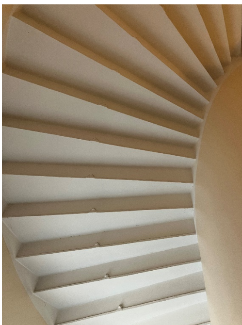
Bild 22 och 23 Trappans gjutjärnssteg.
