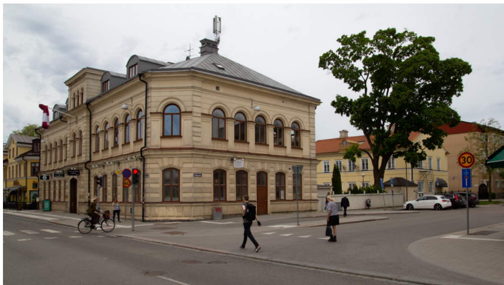
Bild 6 Pantbankshuset från Vaksalagatan vid korsningen med Salagatan (bild: Bjerking).
