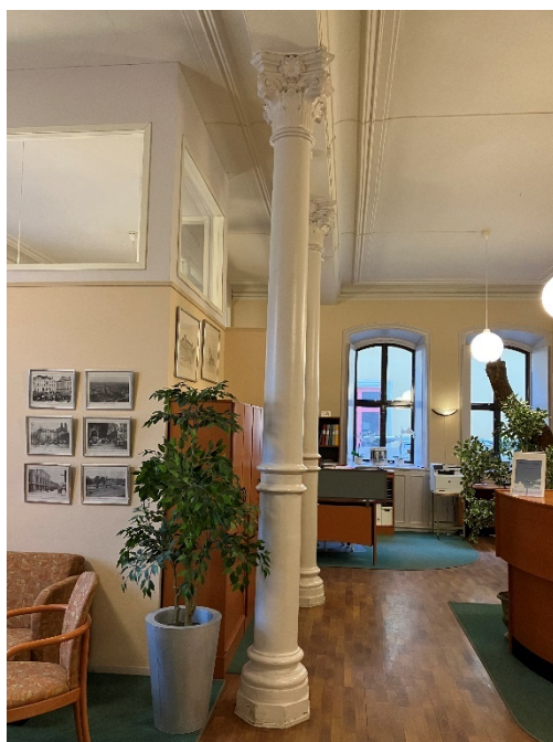
Bild 18 och 19 Ursprungliga gjutjärnskolonner.
