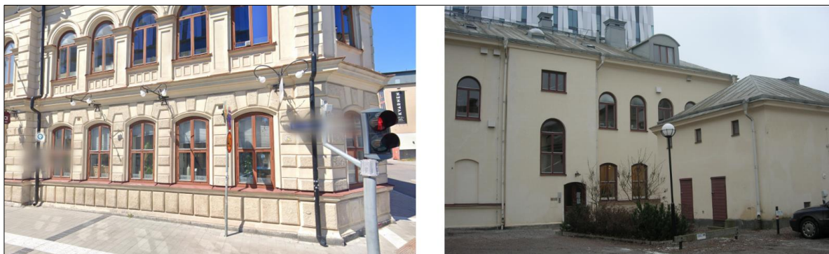
Figur 2a. Stuprör med utkastare mot Vaksalagatan (GoogleMaps, 2021). Figur 2b. Stuprör mot gårdsytan (Fastighetsstudion, 2021).
