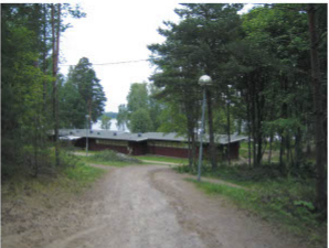
Servicebyggnaden - bakifrån med utsikt över Långsjön.
