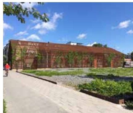
Exempel på inbyggd nätstation, Kungsängen Uppsala
