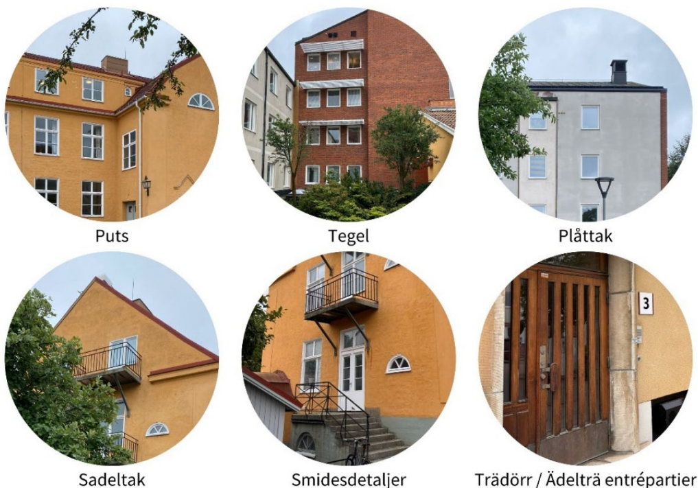
Bild 27. Materialpalett som visar utformning och detaljer på de äldre byggnaderna inom planområdet.
