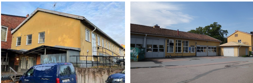
Bild 62-63. Foton som visar hus J sett från söder och sydost. Foto: Link arkitekter (vänster) och Nyréns Arkitektkontor (höger)
