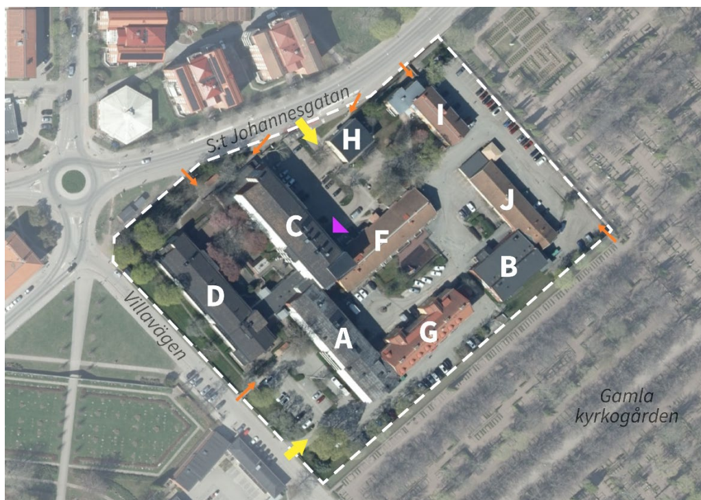
Bild 9. Inzoomad flygbild som visar planområdet och de byggnader som ligger inom det. I texten som följer refereras det till byggnaderna enligt de bokstäver som visas här, det vill säga hus A, hus B, hus C etcetera.
