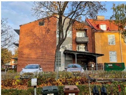
Fasad mot sydöst, lastkaj
