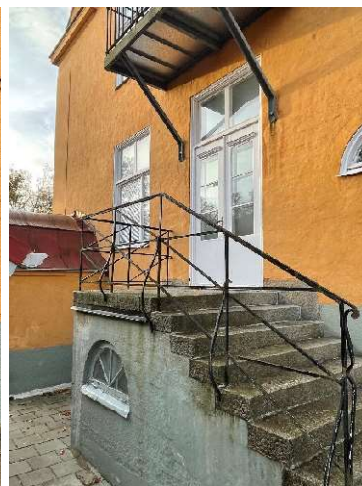
Detalj trappa, räcke, balkongdörr
