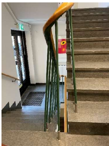
Detalj trappa/räcke, golv
