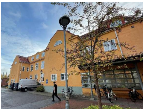
Fasad mot nordväst, ny entré
