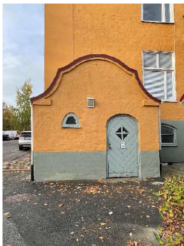
Fasad mot nordost, källarenté
