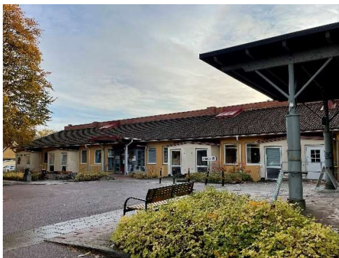
Fasad mot nordväst
