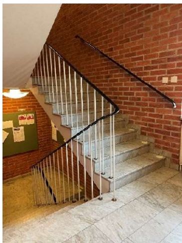
Trappa, räcke, golv, golvsockel
