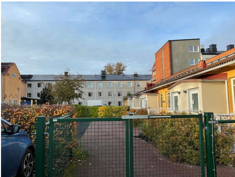
Några av de olika möten mellan byggnades åldrar/stilar som finns i kvarteret. Hus G, A, C, F
