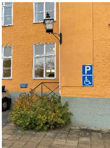
Detalj fönster, räcke, lykta
