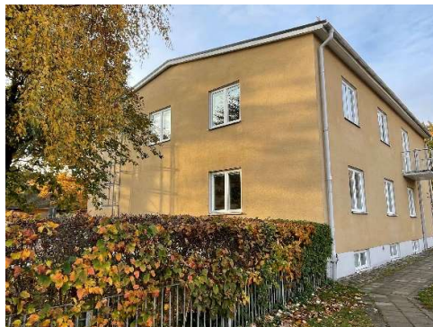
Fasad mot nordväst
