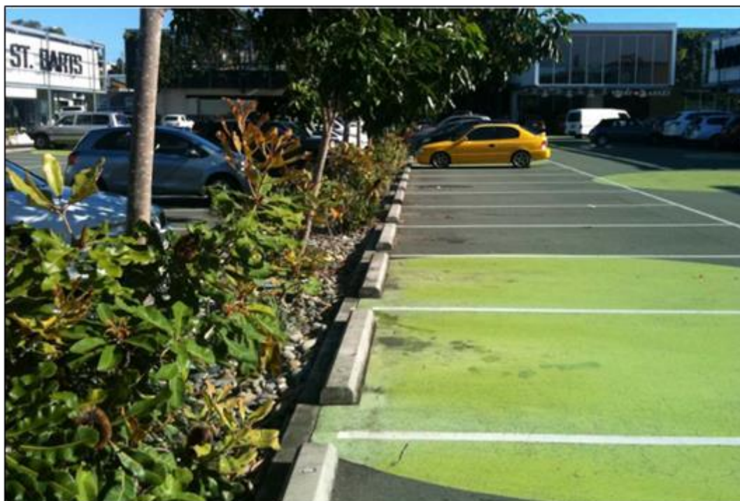
Figur 6-3. Öppning i kantsten, inlopp växtbäddar (Waterbydesign, 2014).
