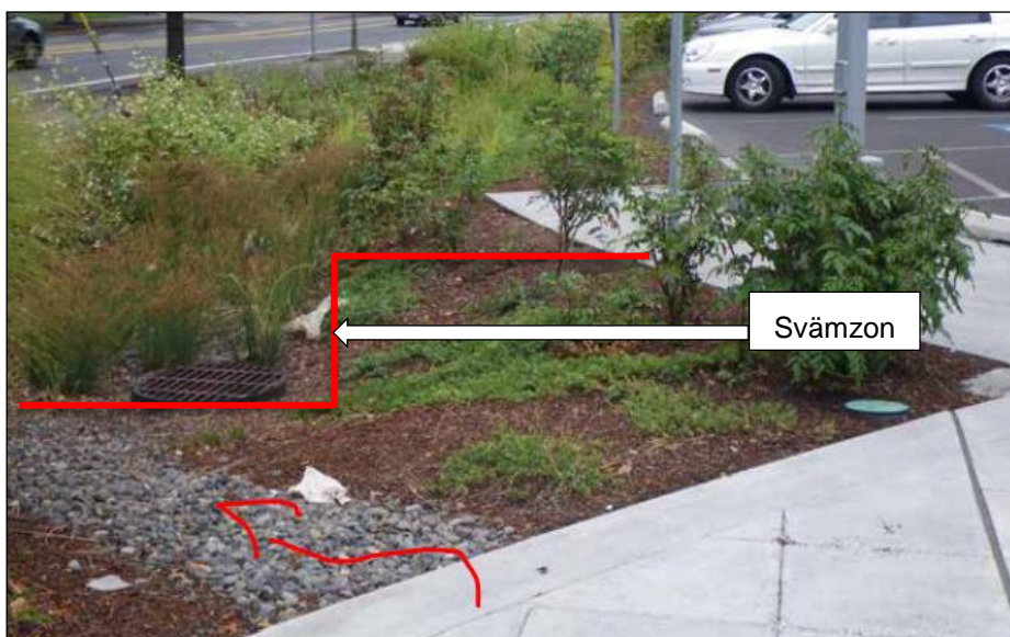
Figur 9. Exempel på nedsänkt planteringsyta med infiltrationsmöjlighet.
