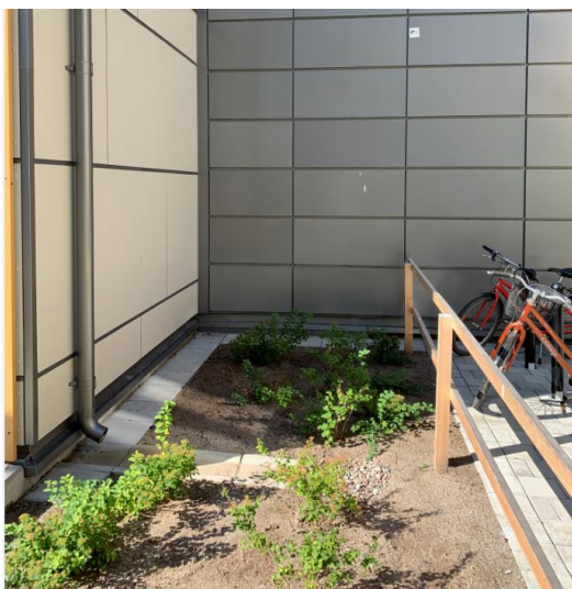
Figur 11. Exempelbild på planteringsyta intill husliv. Takvatten avleds i utvändigt stuprör med utkastare mot planteringsyta via rännal. Vid rännalens utlopp anläggs smågrus vilket fungerar som erosionsskydd. Foto Bjerking AB.
