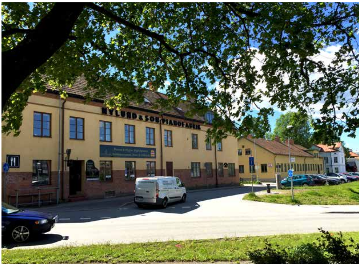
Äldre industribyggnader kommer att vara värdefulla inslag när ny kontors- och bostadsbebyggelse växer fram i Boländerna.
