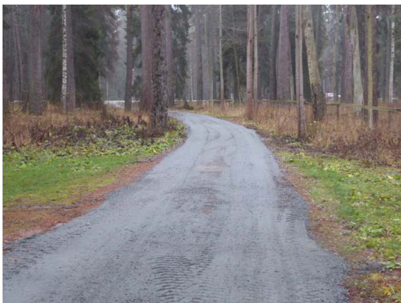
Figur 27 Foto 2 från besiktning innan åtgärder av väg.
