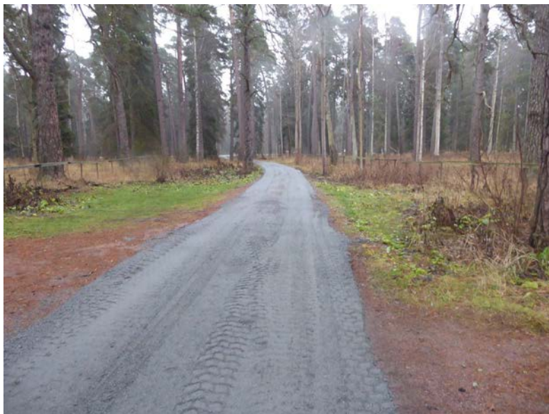
Figur 26 Foto 1 från besiktning innan åtgärder av väg.
