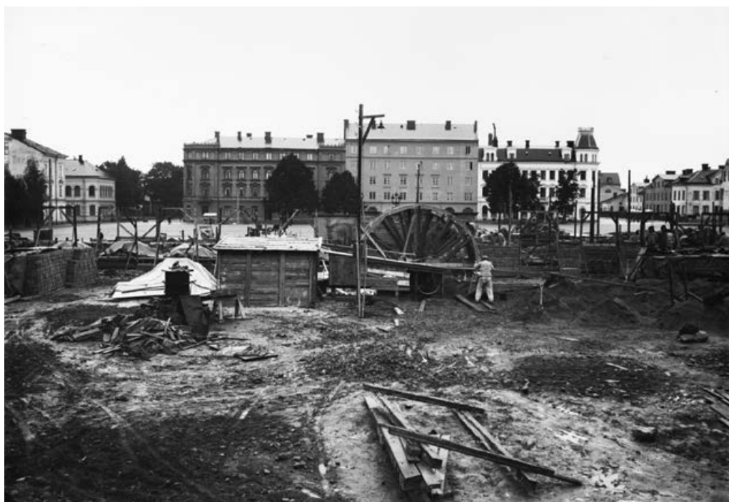
Figur 17 Kvarteret Njord under byggandet av Vaksalaskolan 1925. (Foto: Paul Sandberg, Upplandsmuseet)
