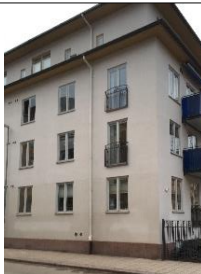
Figur 32 Bild på vitt flerbostadshus i Uppsala med färgkod: S1502-Y. Huset finns på Storgatan 21.
