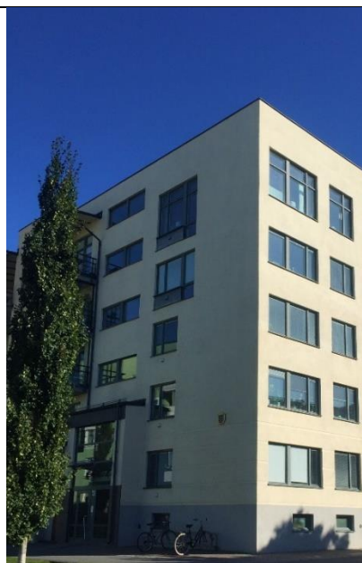
Figur 47 Bild på ett beige flerbostadshus i Uppsala med färgkod: S1515-Y30R. Huset finns på Kapellgärdet.
