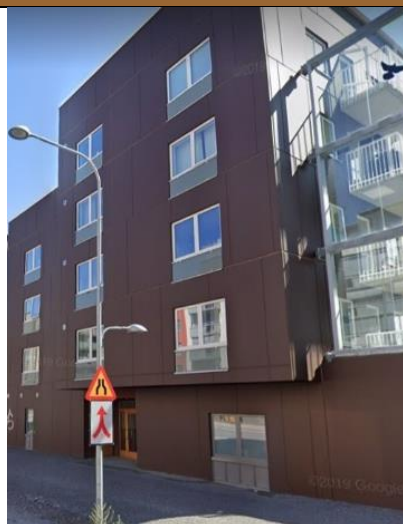
Figur 39 Bild på ett brunt flerbostadshus i Uppsala med färgkod: S8050-Y50R. Huset finns på Råbyvägen.
