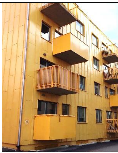
Figur 24 Bild på gult flerbostadshus i Uppsala med färgkod: S1040-Y20R. Huset finns i Rosendal.
