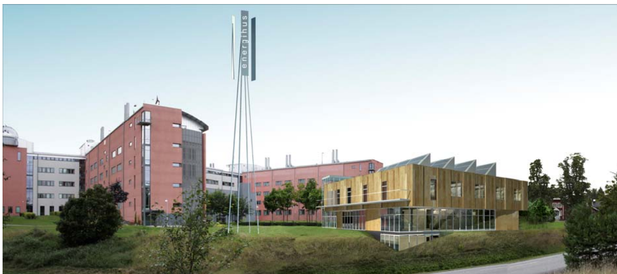
Energihuset sett från sydöst. Kungsängsleden i förgrunden.
