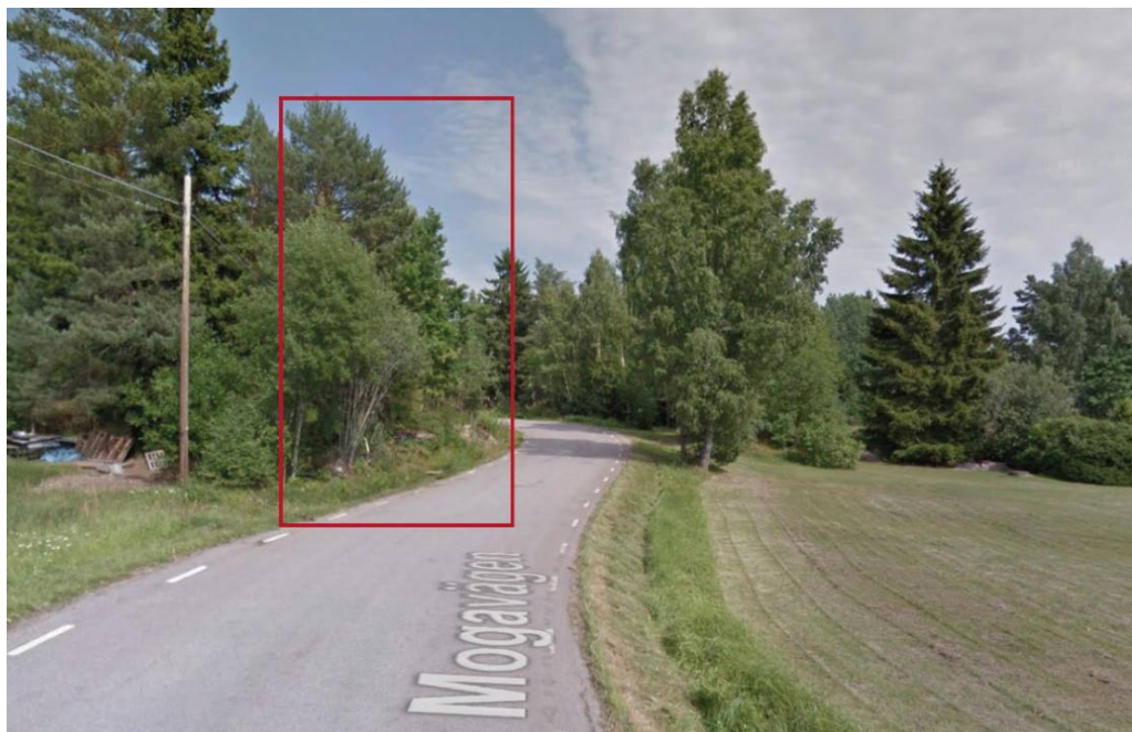
Bild 26 Foto sett från Mogavägen mot öster som visar område som behöver åtgärdas för att uppnå fri sikt (röd ram). Bjerking AB.
