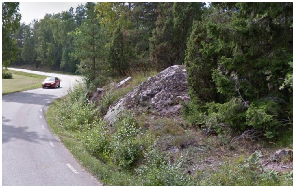
Bild 28 Foto sett från Mogavägen mot söder. I bilden syns en bergknalle som behöver tas bort för att uppnå fri sikt. Bjerking AB.
