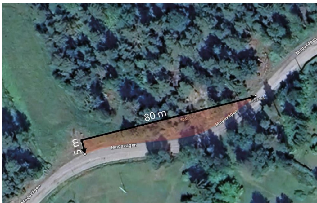
Bild 27 Flygfoto som visar sträcka och område österut längs Mogavägen där fri sikt behöver uppnås. Viss vegetation och en bergknalle behöver tas bort. Bjerking AB.
