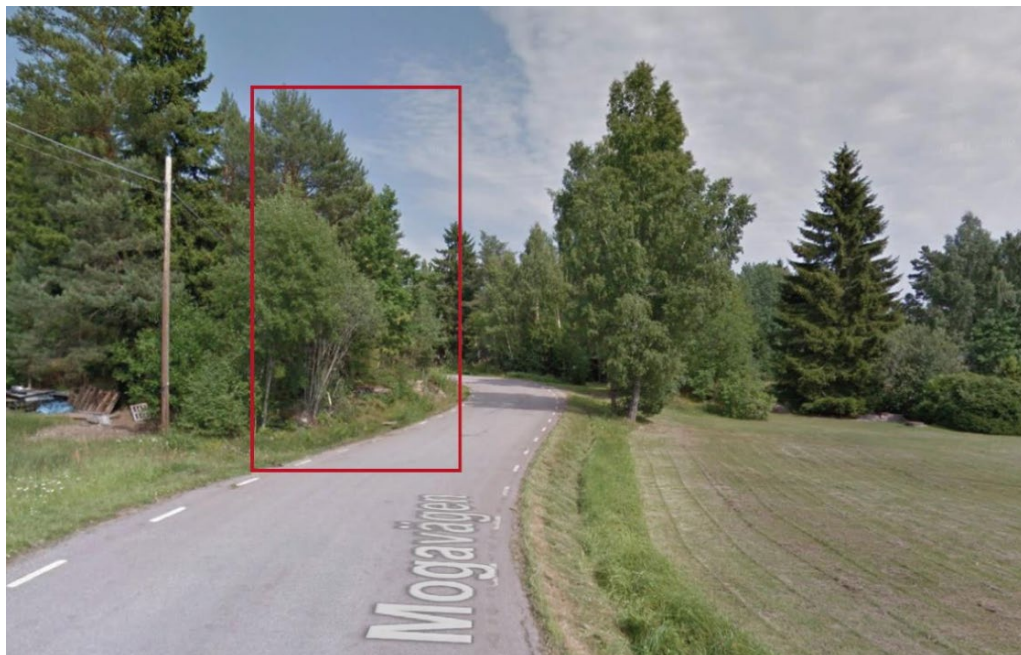
Bild 26 Foto sett från Mogavägen mot öster som visar område som behöver åtgärdas för att uppnå fri sikt (röd ram). Bjerking AB.
