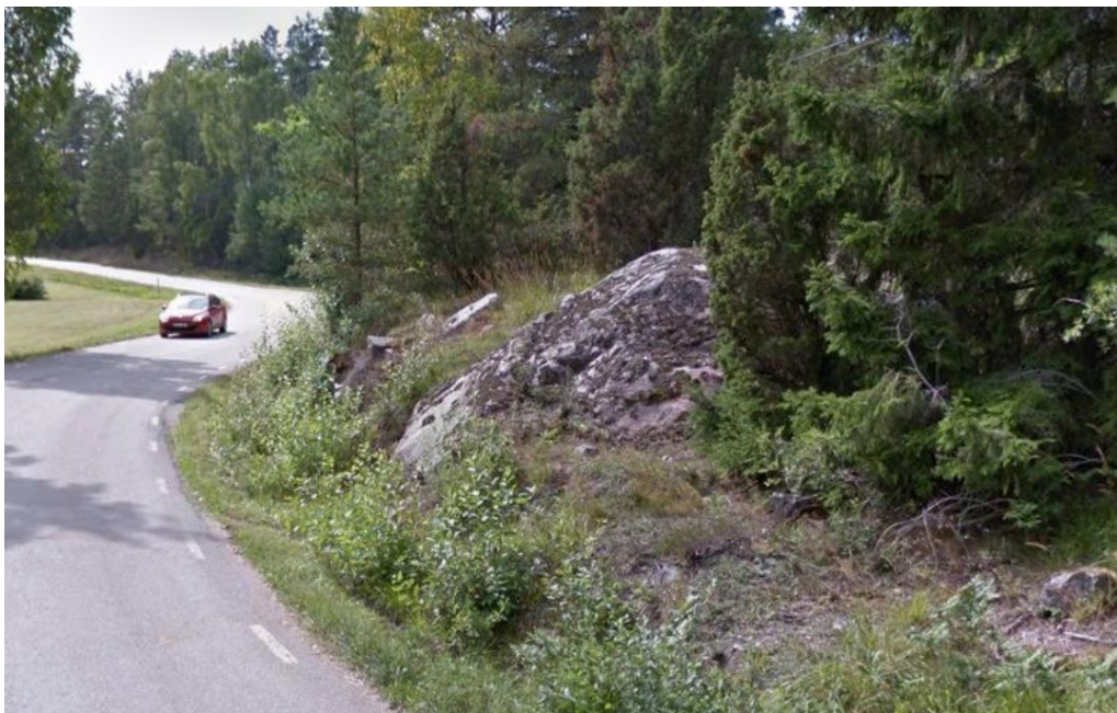
Bild 28 Foto sett från Mogavägen mot söder. I bilden syns en bergknalle som behöver tas bort för att uppnå fri sikt. Bjerkings AB.
