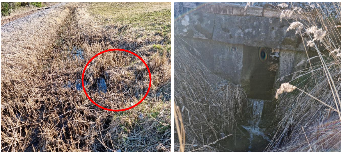
Figur 2-4. Utlopp för dagvattenledning i dike (markerad med röd ring) t.v. och trumma under järnvägsspår t.h.
