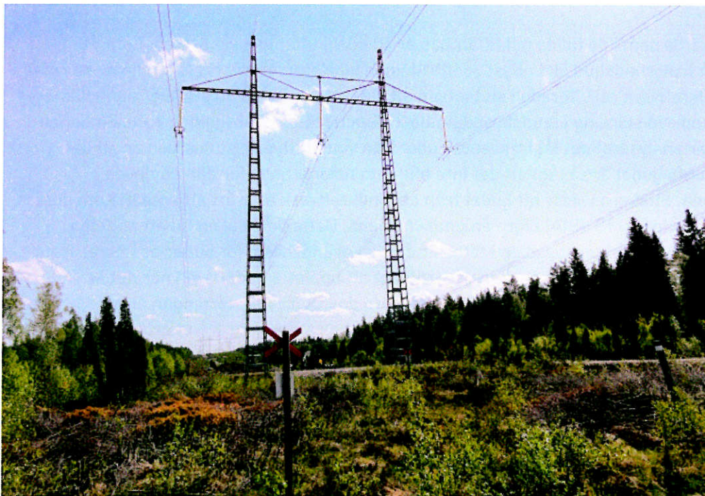
Svenska kraftnäts 400 kV-ledning öster om Siggeforasjön
