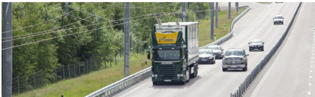
Bild X Demonstrationsprojekt i Sandviken med luftledningar för eldriven godstransport, bild från Trafikverket.
