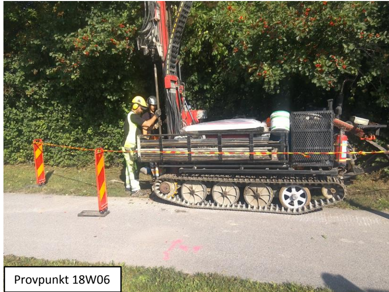
Installation av grundvattenrör
