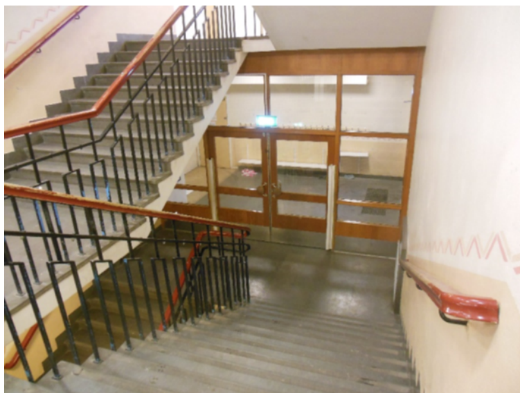
Bild 12 Bilder från trapphusen i den gamla delen av Almtunaskolan. Till vänster ses ett av trapphusen med bevarat träglasparti och trappräcken. Dock är trappräckena förhöjda för att klara modern säkerhetsstandard. Bilden till höger är från invigningsåret 1953.
