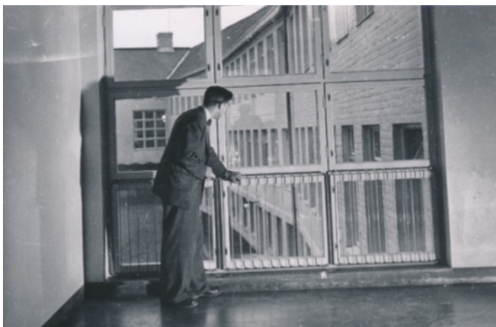
Bild 15 Exempel på mosaik i trapphusen till vänster. Till höger en bild från trapphusets halvplan med generöst glasparti mot skolgården.
