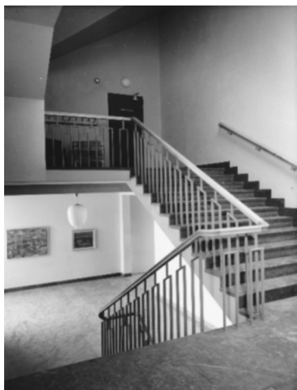
Bild 13 Bilder från trapphusen i den gamla delen av Almtunaskolan. Till vänster ses ett av trapphusen med bevarat träglasparti och trappräcken. Dock är trappräckena förhöjda för att klara modern säkerhetsstandard. Bilden till höger är från invigningsåret 1953.
