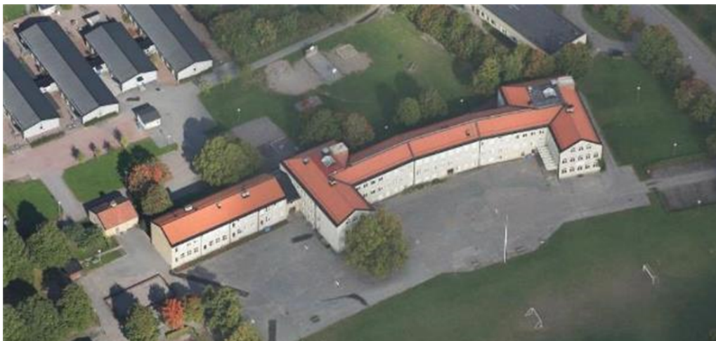
Bild 4 Snedbild från över den äldre delen av Almtunaskolan, södra fasaden (Blom/BlomWEB).
