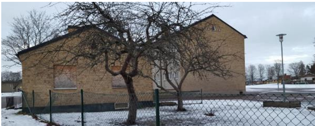
Bild 7 Bild på Almtunaskolans västra gavel. I förgrunden syns den byggnad som tidigare utgjort vaktmästarbostad. Bilden tagen i februari 2016.
