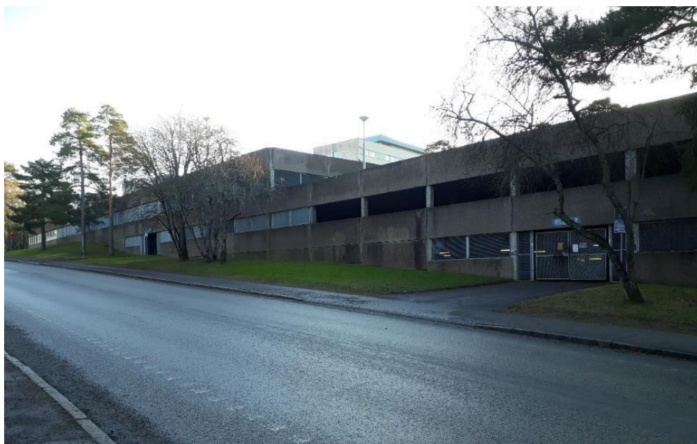
Figur 5 Befintligt parkeringsdäck inom Flogsta 13:2.
