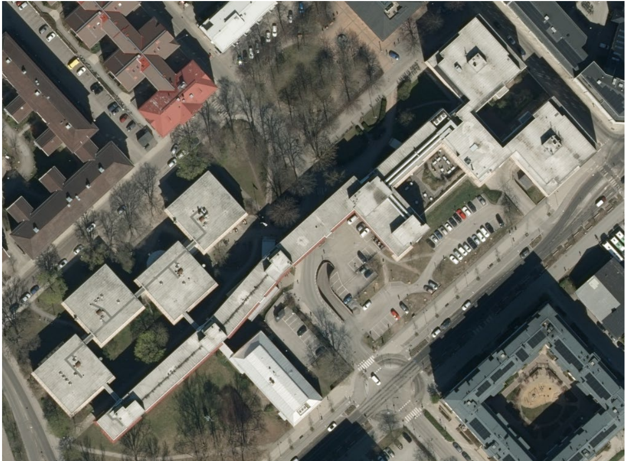
Flygfoto över byggnaderna inom kvarteret Hugin idag.
