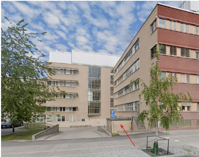
Bild som visar läget för den befintliga elstationen i kvarter B vid Strandbodgatan, Alma arkitekter.
