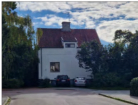
Nordvästra fasaden på huset inom Fålhagen 60:1.
