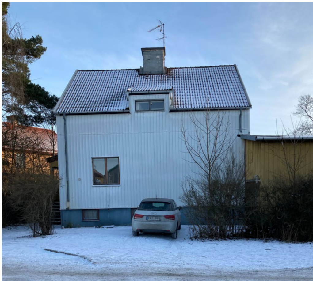
Figur 18. Befintlig byggnad i februari 2023.
