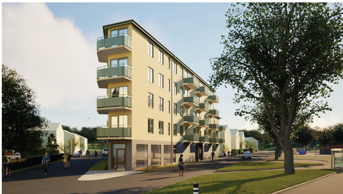
Figur 11. Byggnaden sedd från Fålhagsleden. Källa: Torget Arkitekter
