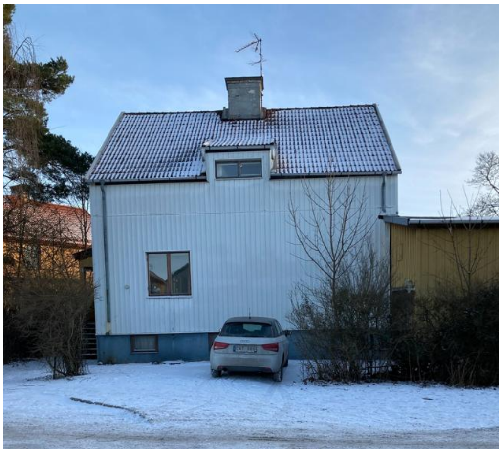
Figur 18. Befintlig byggnad i februari 2023.
