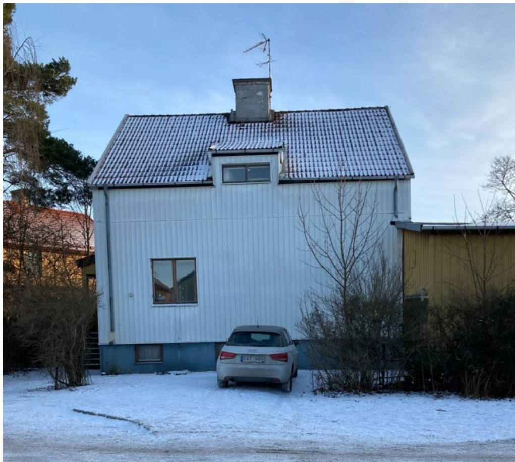
Figur 17. Befintlig byggnad i februari 2023.
