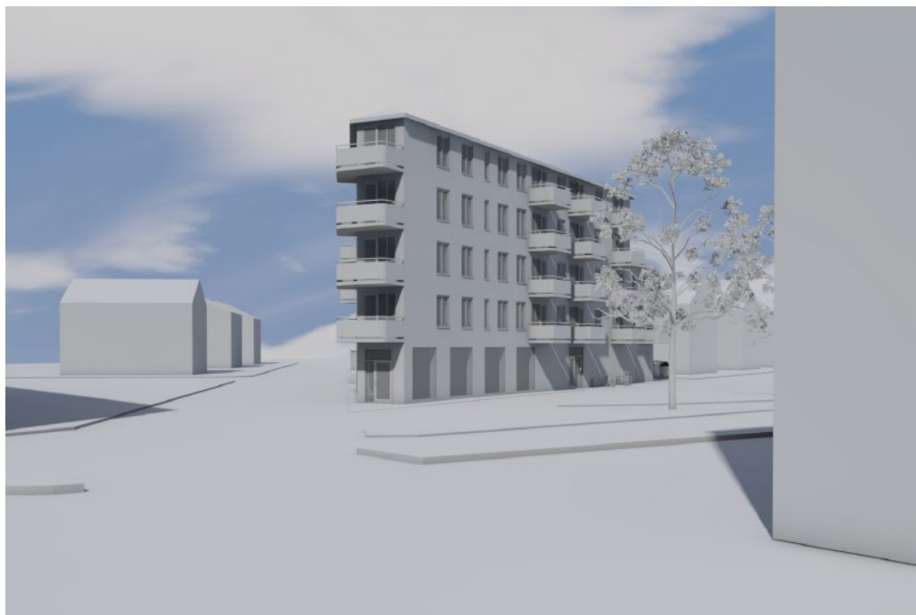
Figur 12. Byggnaden sedd från Fålhagsleden. Källa: Torget Arkitekter
