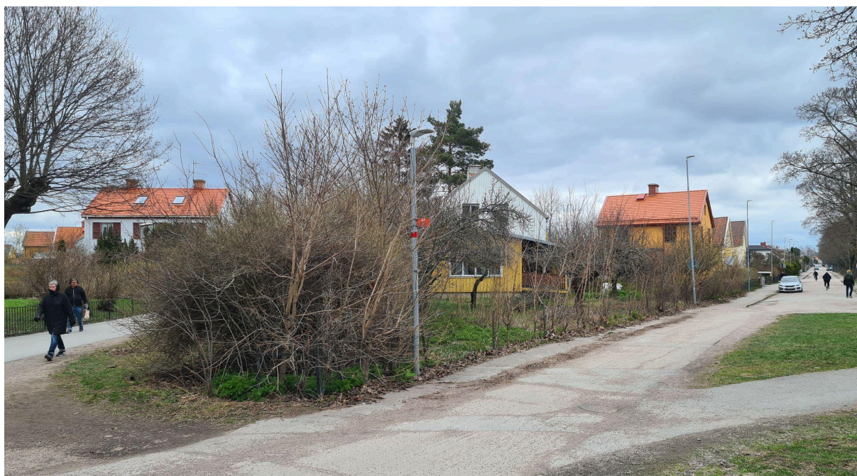
Bild från undersökningen som visar fastigheten från väster. Källa VFG Teknik.
