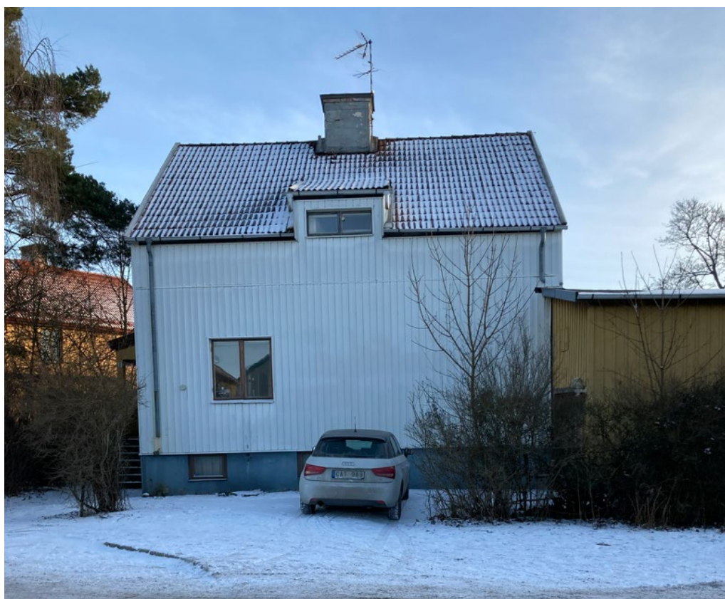
Figur 3 Befintlig byggnad i februari 2023.
