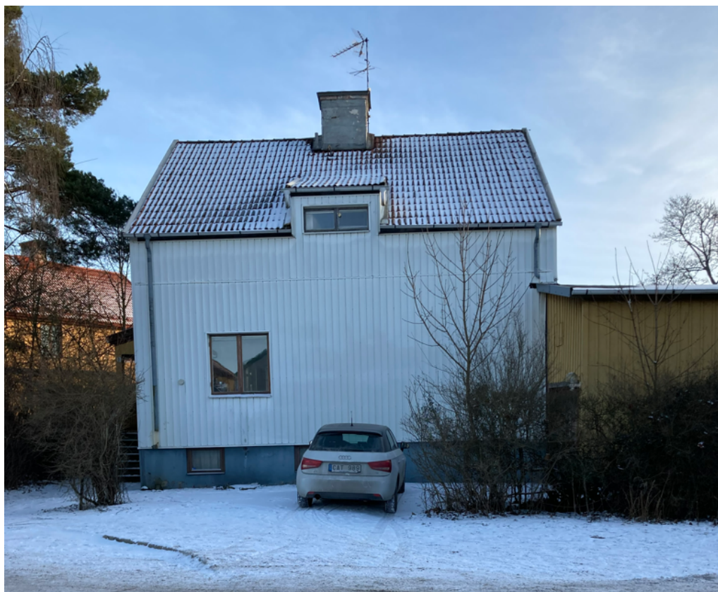
Figur 3. Befintlig byggnad i februari 2023.
