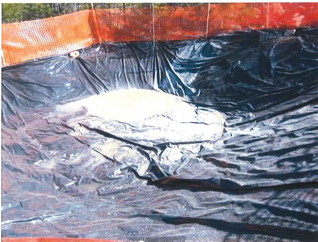
Figur 5. Omhändertagande av spillvatten från betongtillverkning. Detta anläggs tillfälligt då tillverkning sker såsom på bilden.
