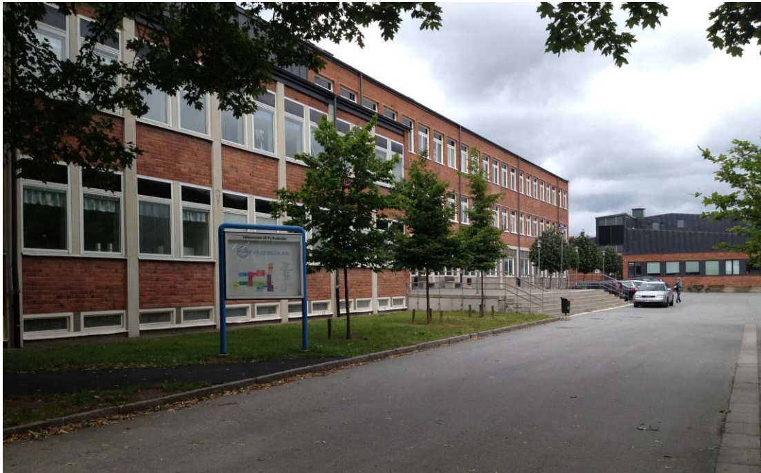
Fyrissskolans södra del med huvudentré som vetter mot Luthagsesplanaden, till höger i bild syns teknikbyggnaden som behöver rivas för att möjliggöra ny bebyggelse, Archus.
