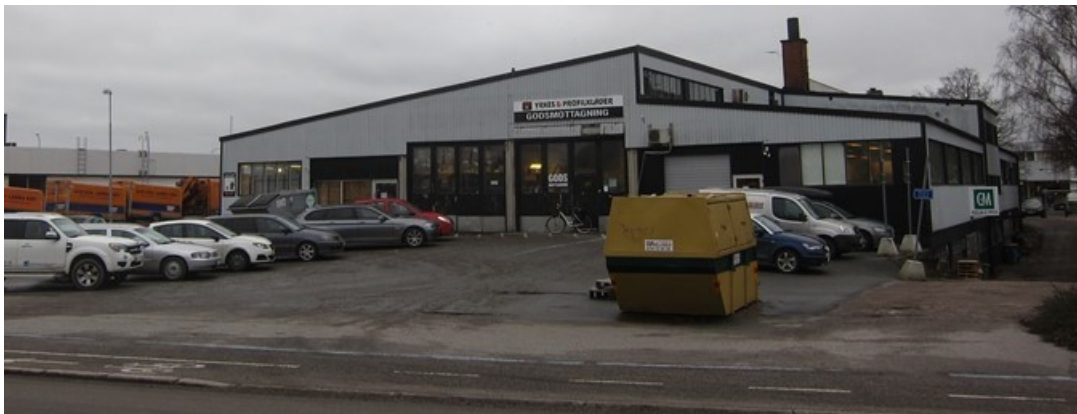
Befintlig byggnad sedd från Vimpelgatan
