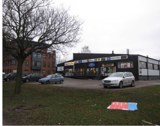
Den befintliga byggnaden sedd från Kungsgatan
