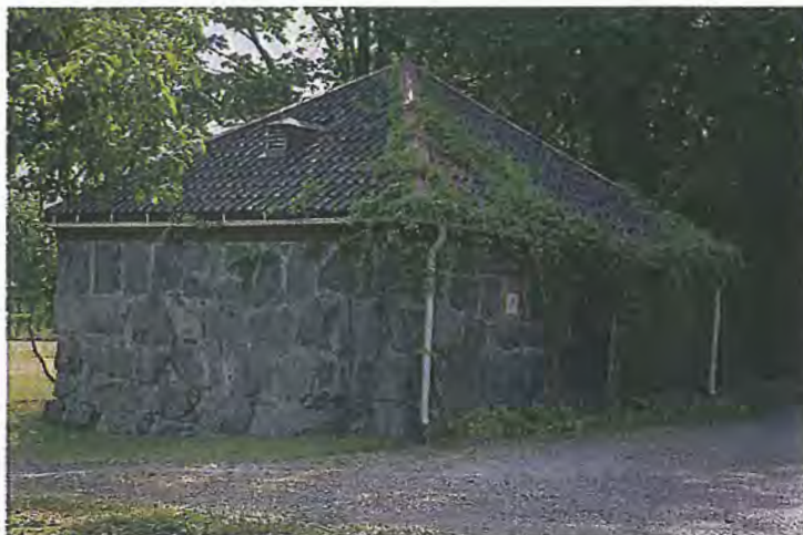
Fruktkällaren (foto: Hanna Schill, byggnadsantikvarie)
