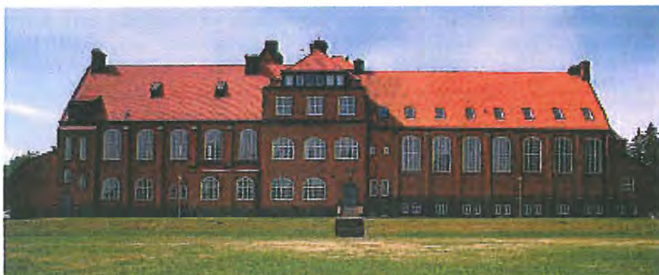
Lärarseminariets nordöstra fasad. (foto: Hanna Schill, byggnadsantikvarie)
