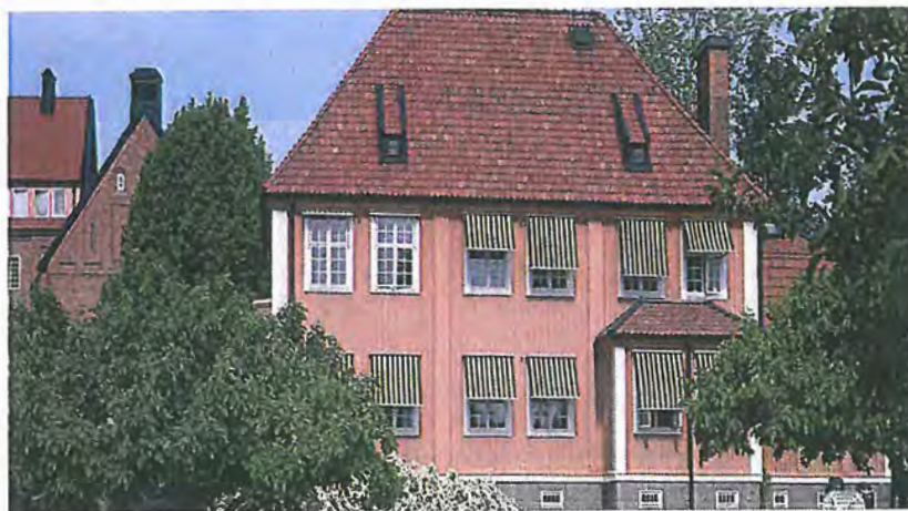
Rektorsvillan (foto: Hanna Schill, byggnadsantikvarie)
