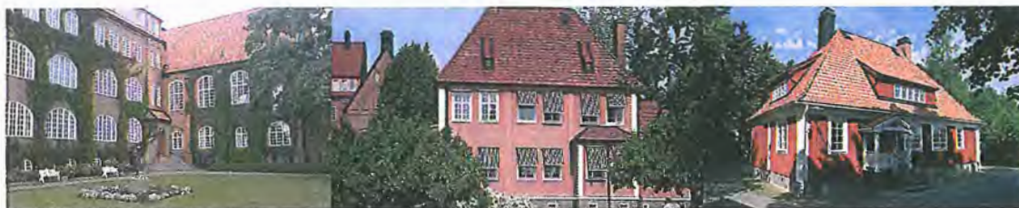
Seminariebyggnaden, Rektorsvillan och Vaktmästarbostaden
