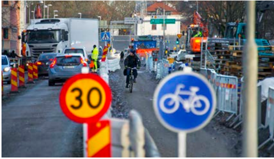
Exempel på trafikomledning vid pågående gatuombyggnad.
