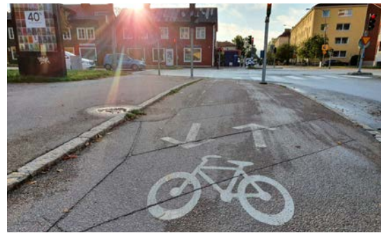
Foto över cykeldetektering utmed Torkelsgatan där slingor i marken känner av att cyklisten närmar sig den signalreglerade korsningen.
