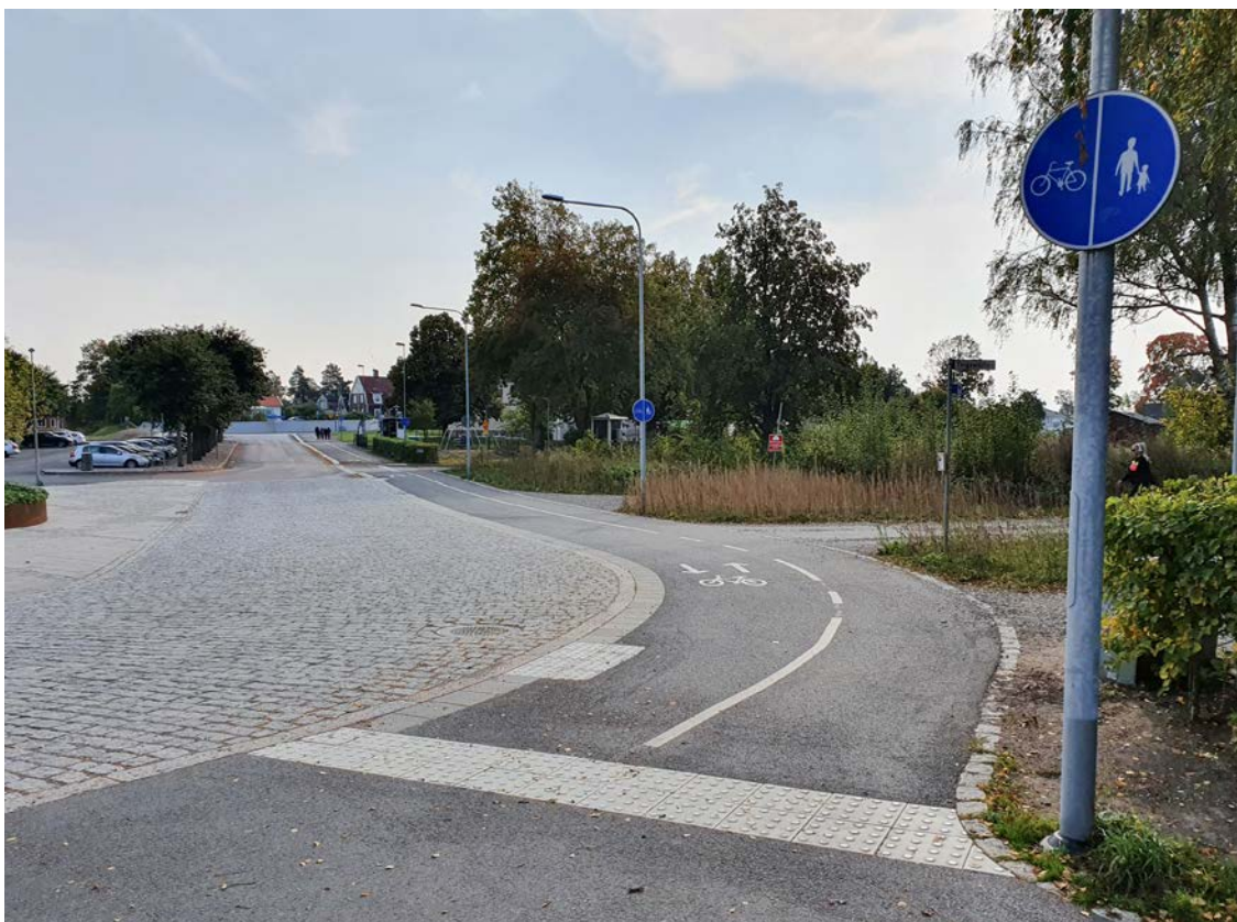
Foto från Groaplan i Gamla Uppsala där Uppsala kommun under 2019 minskade körbanans bredd för att inrymma plats för en cykelbana.
