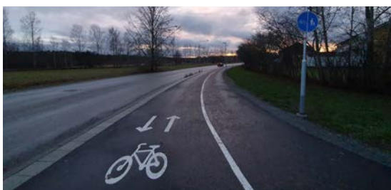
Uppdelning av fotgängare och cyklister genom målning och skyltning vid gång- och cykelbana utmed Flogstavägen i Flogsta.
