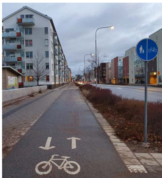
Exempel på uppdelning av fotgängare och cyklister genom olika beläggningsmaterial och skyltning vid gång- och cykelbana utmed Råbyvägen i centrala Uppsala.
