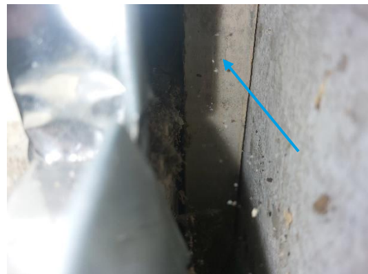
Foto 4 träläkt direkt mot källarvägg
