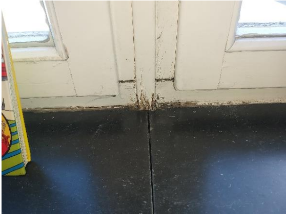
Foto 24 vybild över provplats MP1
