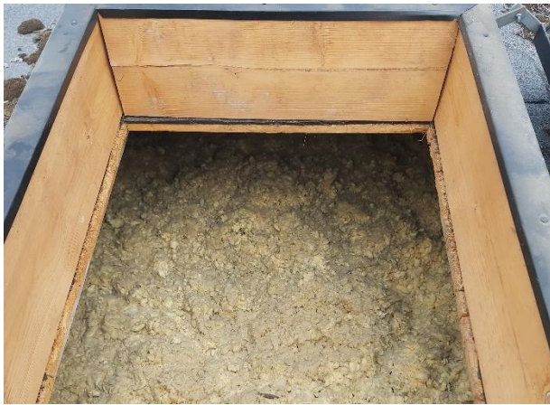
Foto 7 tacklucka byggad D
