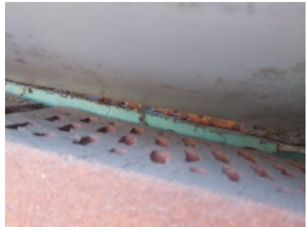
Foto 2 tegelhålstén under plåt
