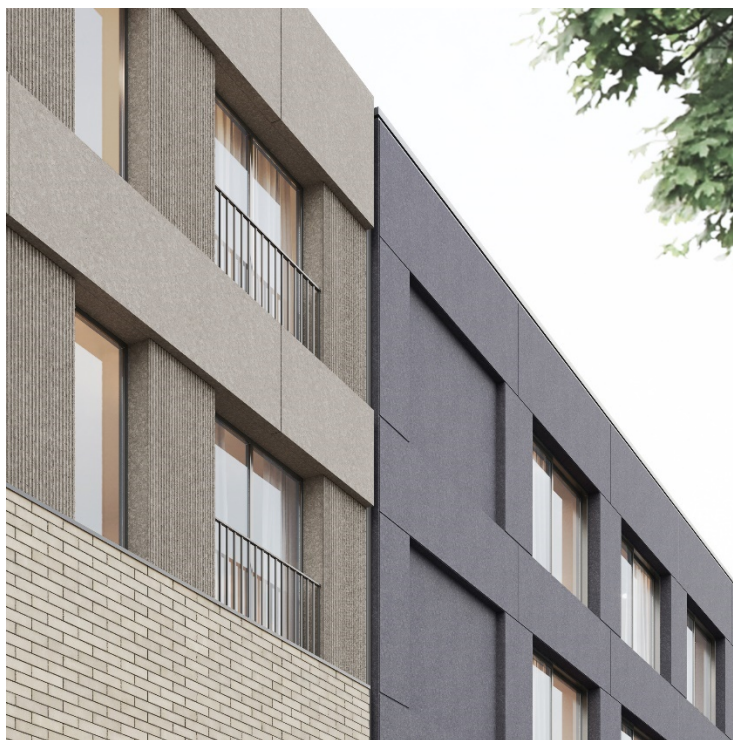
Figur 11 Illustration som visar hur påbyggnadens fasad med fibercementskivor möter tegelfasaden.
