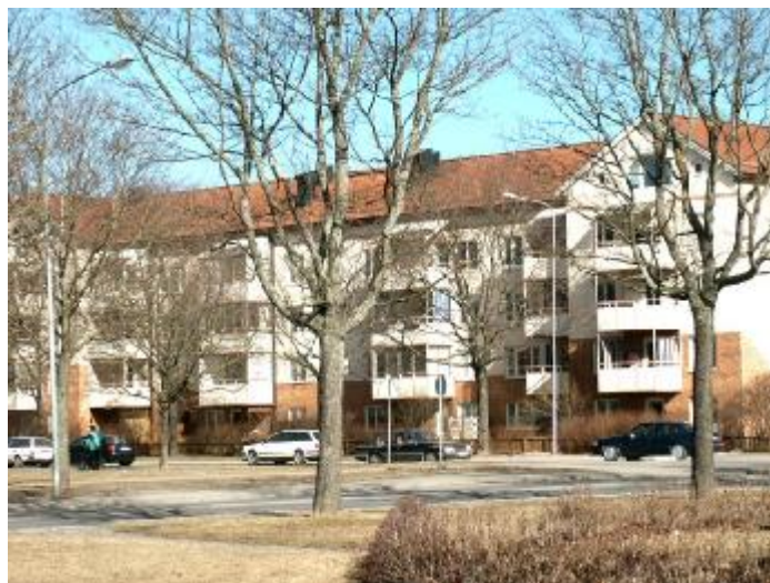
Exempel på befintlig bebyggelse
