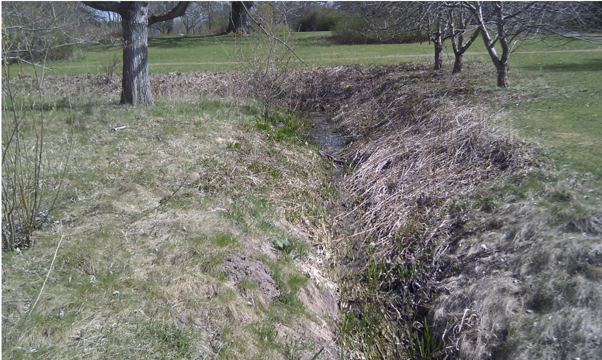
Nedersta delen av det dike, som avses fyllas igen.
