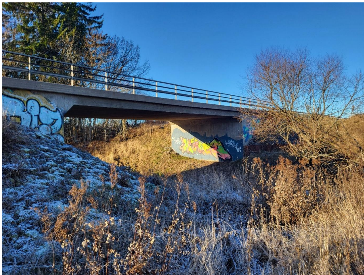
Figur 3 Befintlig vägbro för väg 272 över Jumkilsån. Gång- och cykelbron (broläge 2) planeras att anläggas intill befintlig vägbro på dess östra sida. Foto: Uppsala kommun.
