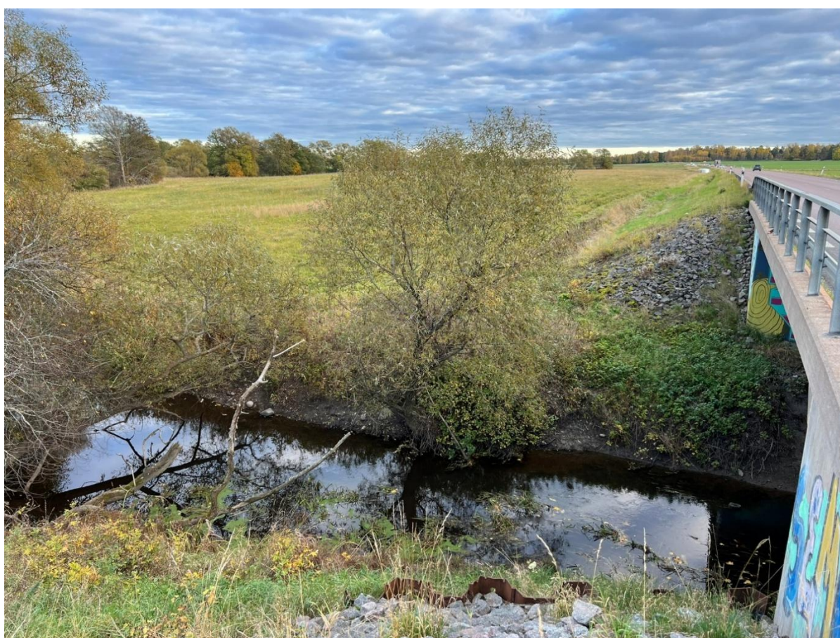
Figur 11 Vy från befintlig vägbro för väg 272 över Jumkilsån i riktning mot sydväst. Den planerade bron (broläge 2) anläggs cirka 20 meter öster om den befintliga bron (till vänster om bron i bilden).
