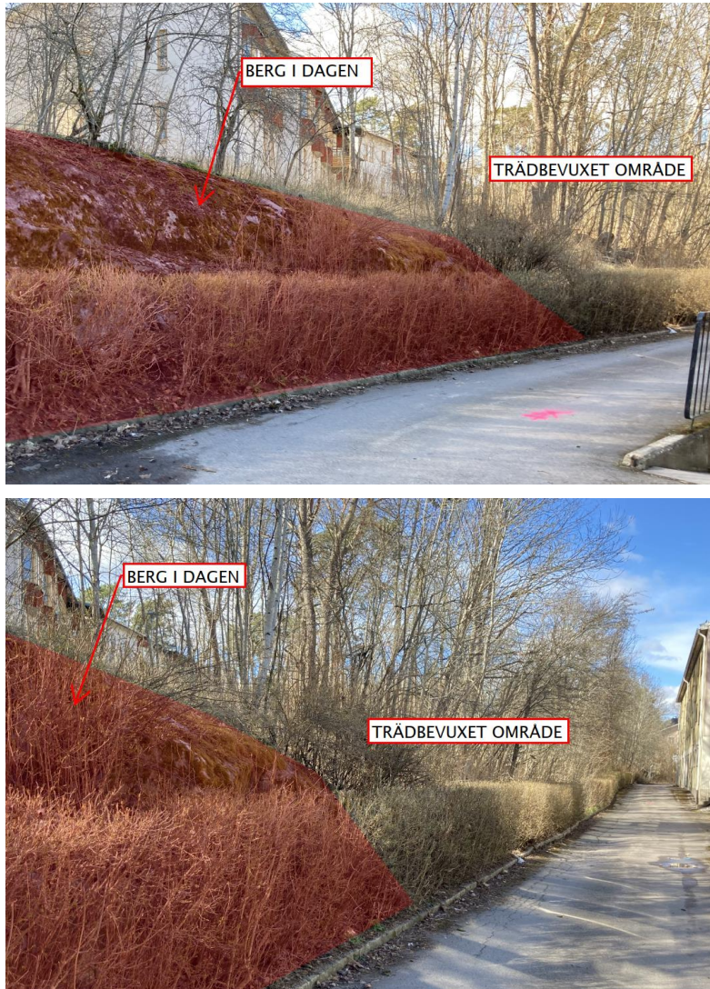
Figur 2: Översikt över undersökningsområdets sydvästra och västra del
