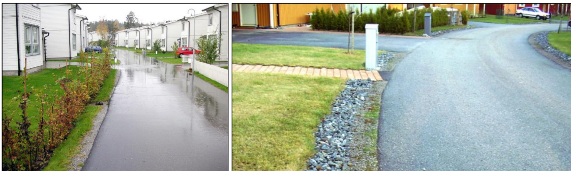
Figur 6-2. Exempel på utformning av avledning av dagvatten från vägar via makadamdike (Stockholm Vatten & Avfall, 2021a).
