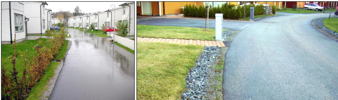
Figur 6-2. Exempel på utformning av avledning av dagvatten från gator via makadamdike (Stockholm Vatten & Avfall, 2021a).
