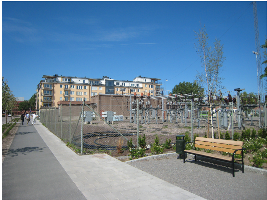
Figur 2. Anläggningen idag sett söderifrån Muningatan.
