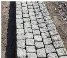
Tillägg: Dagvattenrännan i gatsten
