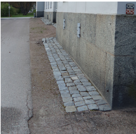
Befintliga friser av gatsten mot fasad.
